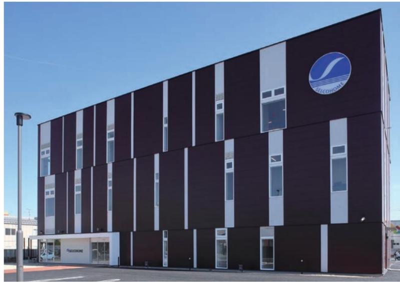
仙台市宮城野区苦竹に完成した「シティフォレスト宮城野ビル」の外観。耐震性や気密性に優れた「カナダ2×4工法」と集成材を活かした木造ハイブリッド大規模木造建物だ
